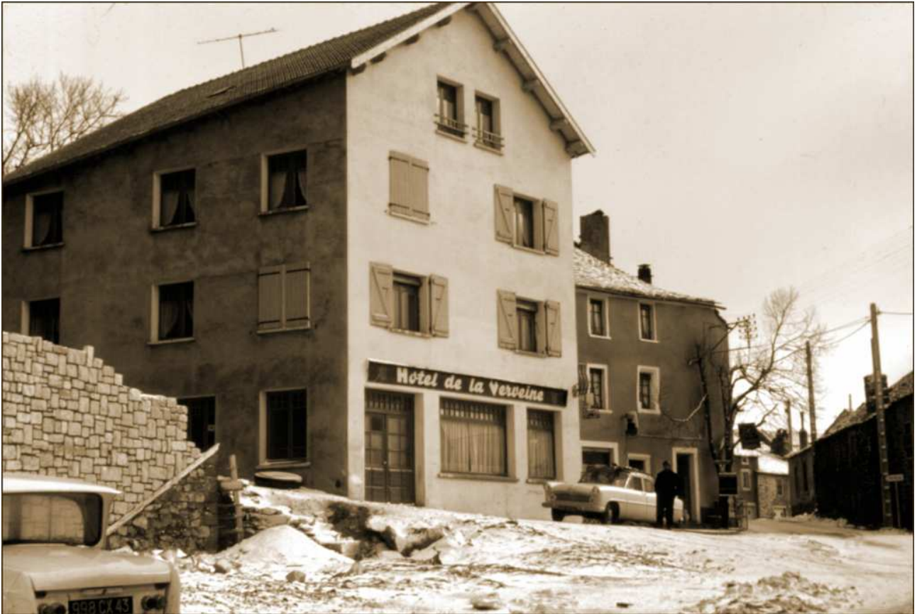
À gauche de La Blache (Parcelle 399), le grand escalier de l'église en construction (1965).
