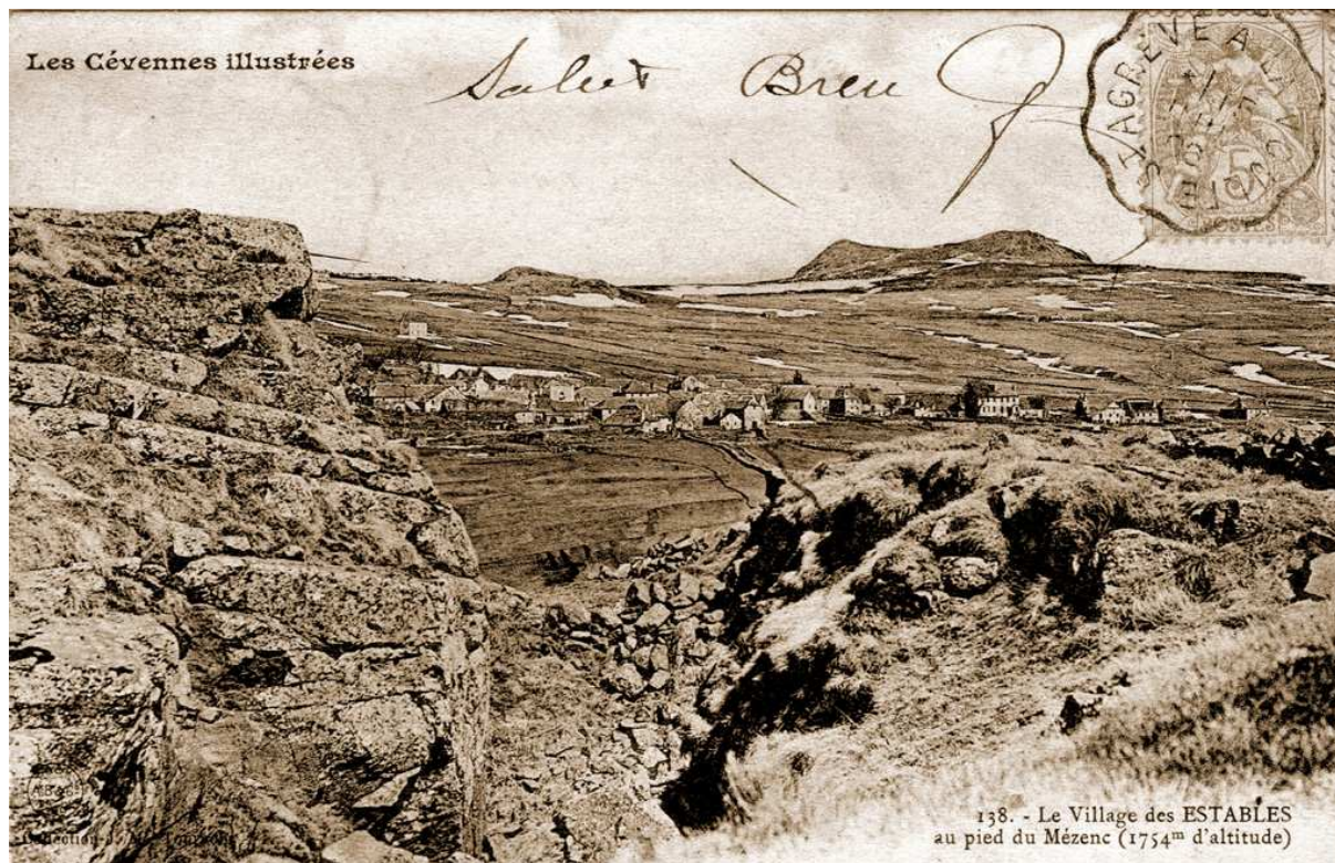
Cette carte postale peut être datée de l'année 1905 : L'église est construite jusqu'à la chambre des cloches
