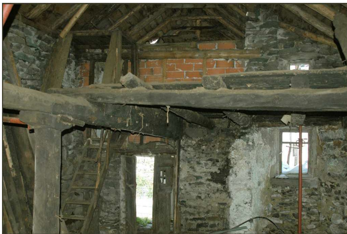
L'écurie et la montée d'escalier
