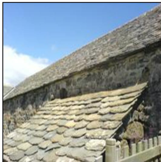
Photo. 26 : Toit de lauze
